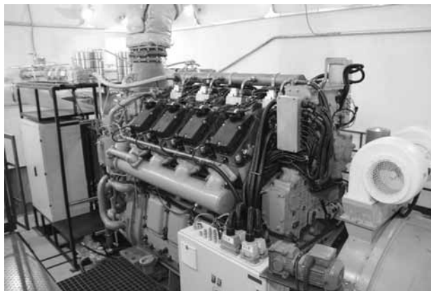
Рис. 1. Газовый двигатель-генератор 9ГМГ
