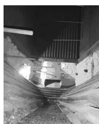
Рис. 4. Расстановка термопар в топке котла
