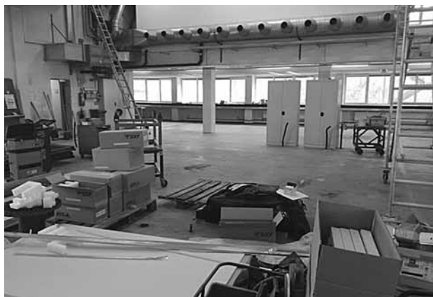
Рис. 2. Переоборудование существующего цеха
