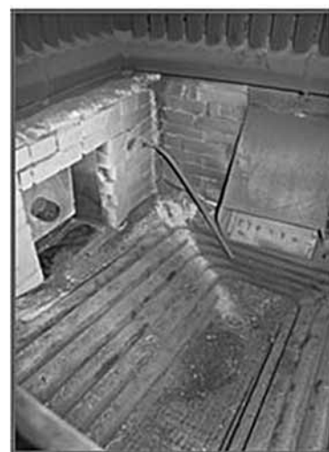
Рис. 11. Фото котла ВТКС с пусковой горелкой на дизельном топливе
