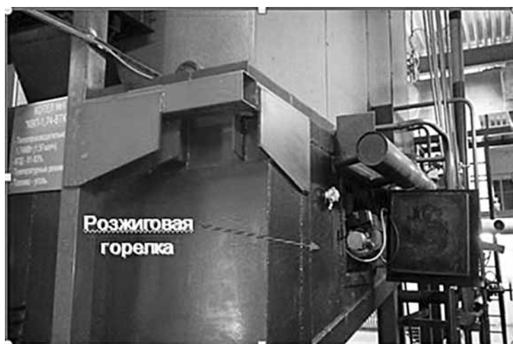
Рис. 11. Фото котла ВТКС с пусковой горелкой на дизельном топливе
